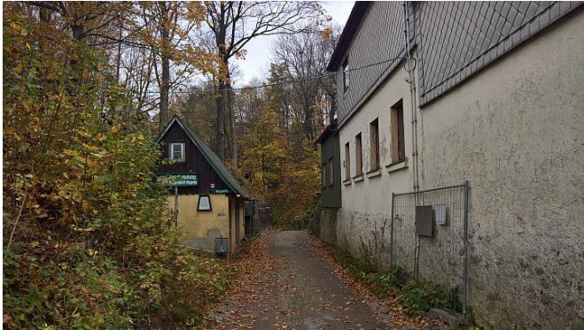
Abbildung 58: Hauptzugang Binge Deutschneudorfer Straße mit Sanitärgebäude (links)
