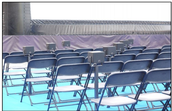
Abbildung 67 Beispiele: Line Array für Zentralbeschallung (links) und Kompaktlautsprecher für Dezentralbeschallung (rechts)
